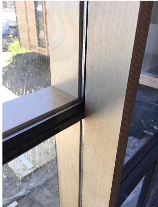
L'accueil de jour est une construction à **ossature en bois, démontable** (process Nano d'Univers et Conseils). Une large façade vitrée éclaire abondamment une salle de réunion. Réaliser cette paroi avec du double vitrage de réemploi était une opportunité pour tester une solution très isolante avec **deux couches de double-vitrage**.
